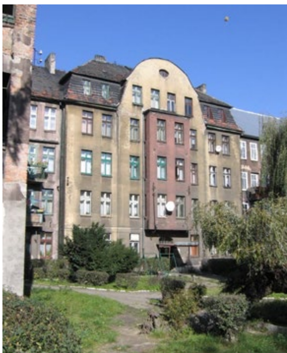
Rys. 5. Zabytkowa kamienica przy ul. Mikołowskiej w Mysławicach przed renowacją
