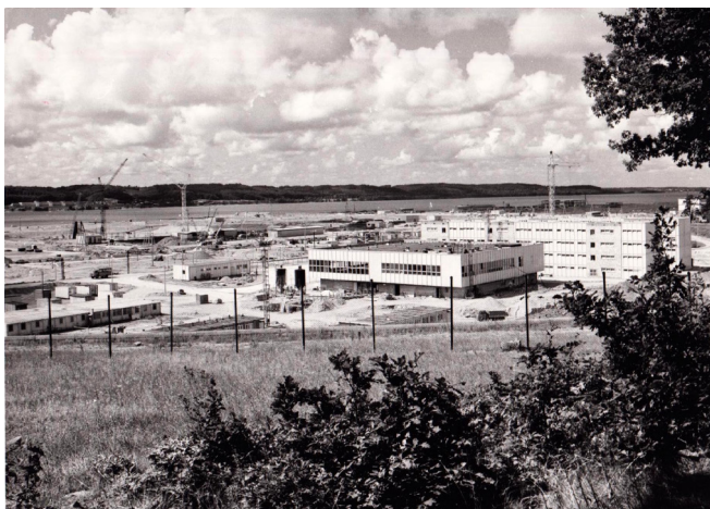
Fot. 3. Stacja na budowie, stołówka, szatniowce oraz kotłownia, 1987 r.
