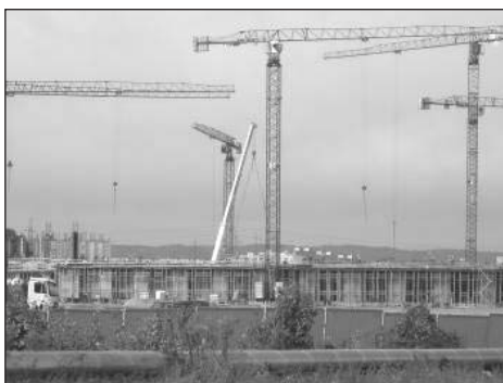
Budowa stadionu Baltic Arena w Gdańsku
