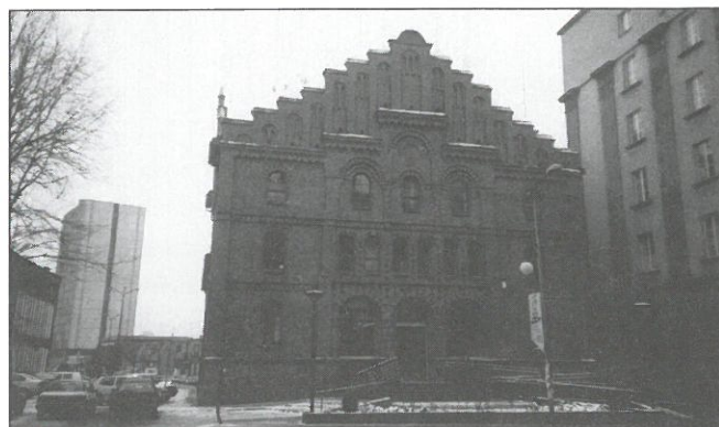
Zmodernizowany budynek dawnej pralni – obecnie siedziba PZU O/Katowice
