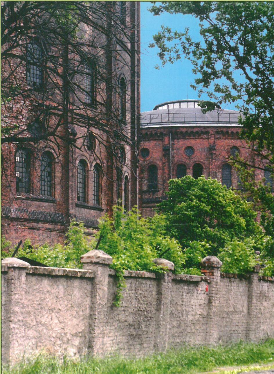
Stara gazownia warszawska – fot. A. Oleszczuk
